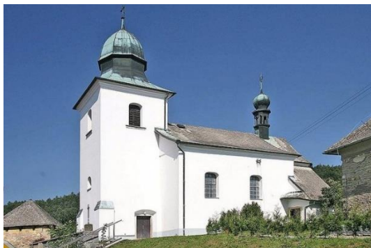
Obrázek 6: Kostel Božího Těla/sv. Havla ve středu Vrbatova Kostelce
